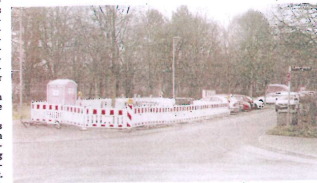
Hier fallen Parkplätze weg – zur Lagerung von Material.
