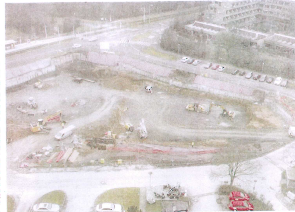
Durch die große Baustelle am Julius-Brecht-Haus sind 280 Parkplätze weggefallen. Es herrscht Parkplatznot.
